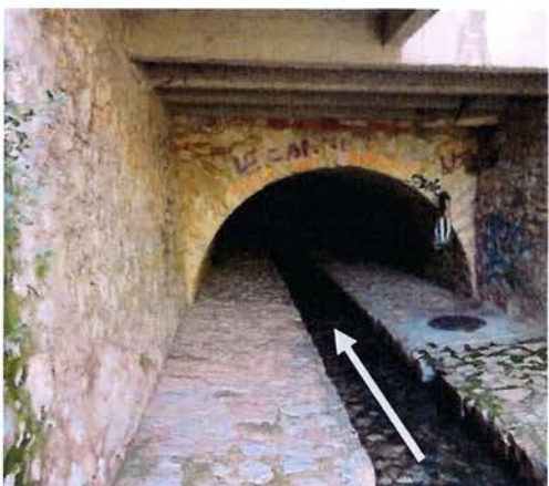
Figure 17 : Photographie de l'ouvrage voûté sous la rue d'Ormesson
