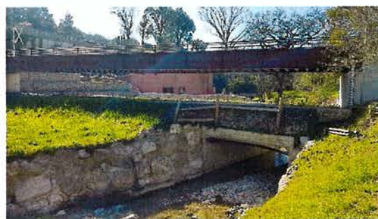
Figure 8 : La Grande Frayère au droit du bassin de rétention du SIFRO
