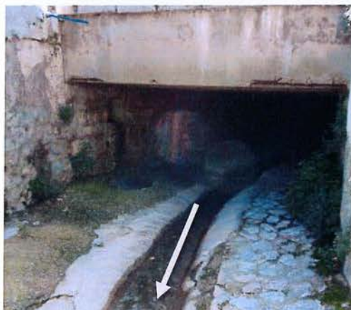
Figure 20 : Photographie de la partie souterraine sous le rond-point au droit de la rue Frédéric Mistral et de l'avenue de Lacour
