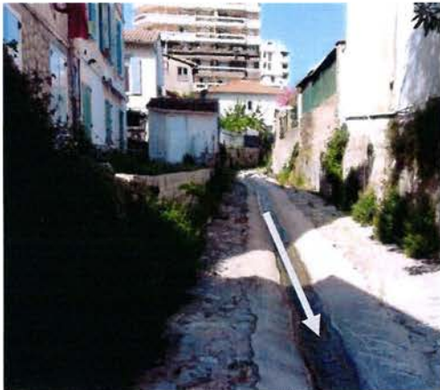
Figure 21 : Photographie du tronçon aérien entre la rue Mérimée et le rond-point au droit de la rue Frédéric Mistral et de l'avenue de Lacour
