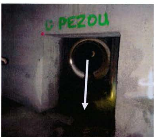
Figure 16 : Photographie de la confluence entre le Pezou et la Foux – Radier dégradé
