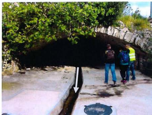
Figure 9 : Photographie de l'ouvrage voûté
