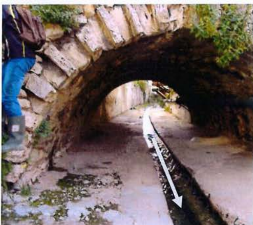
Figure 13 : Photographie de l'ouvrage voûté sous l'avenue de la Baronne
