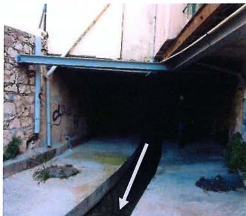
Figure 18 : Photographie de la partie souterraine entre le rue d'Ormesson et la rue de Cannes
