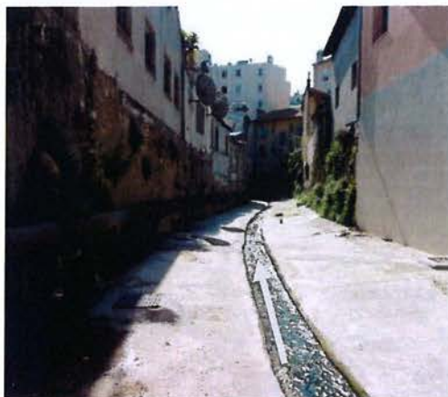
Figure 12 : Photographie de la Foux entre l'avenue de la Baronne et la rue Boucicaut
