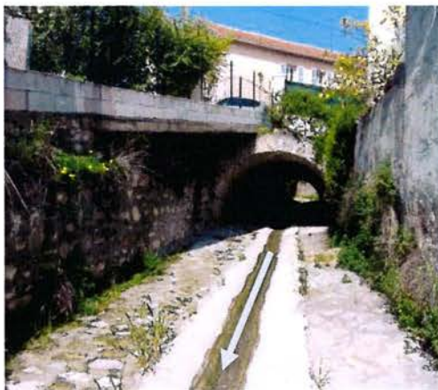
Figure 22 : Photographie de l'ouvrage voûté sous la rue de Mérimée
