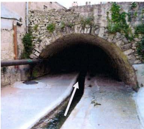
Figure 11 : Photographie de l'entrée de la partie voûtée sous la rue Boucicaut
