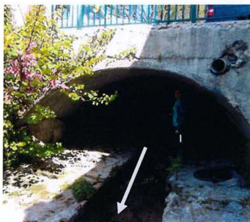
Figure 19 : Photographie de l'ouvrage voûté sous la rue de Cannes
