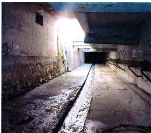
Figure 15 : Photographie de la partie canalisée au droit de l'avenue des Anglais
